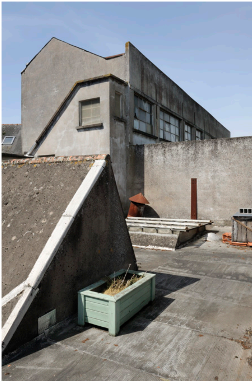
Vue du bâtiment construit en 1948, depuis le toit terrasse de la première usine.
