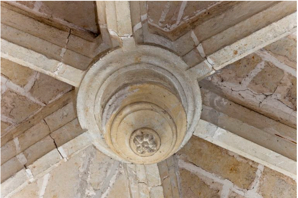
Clé de la voûte de la travée I.
