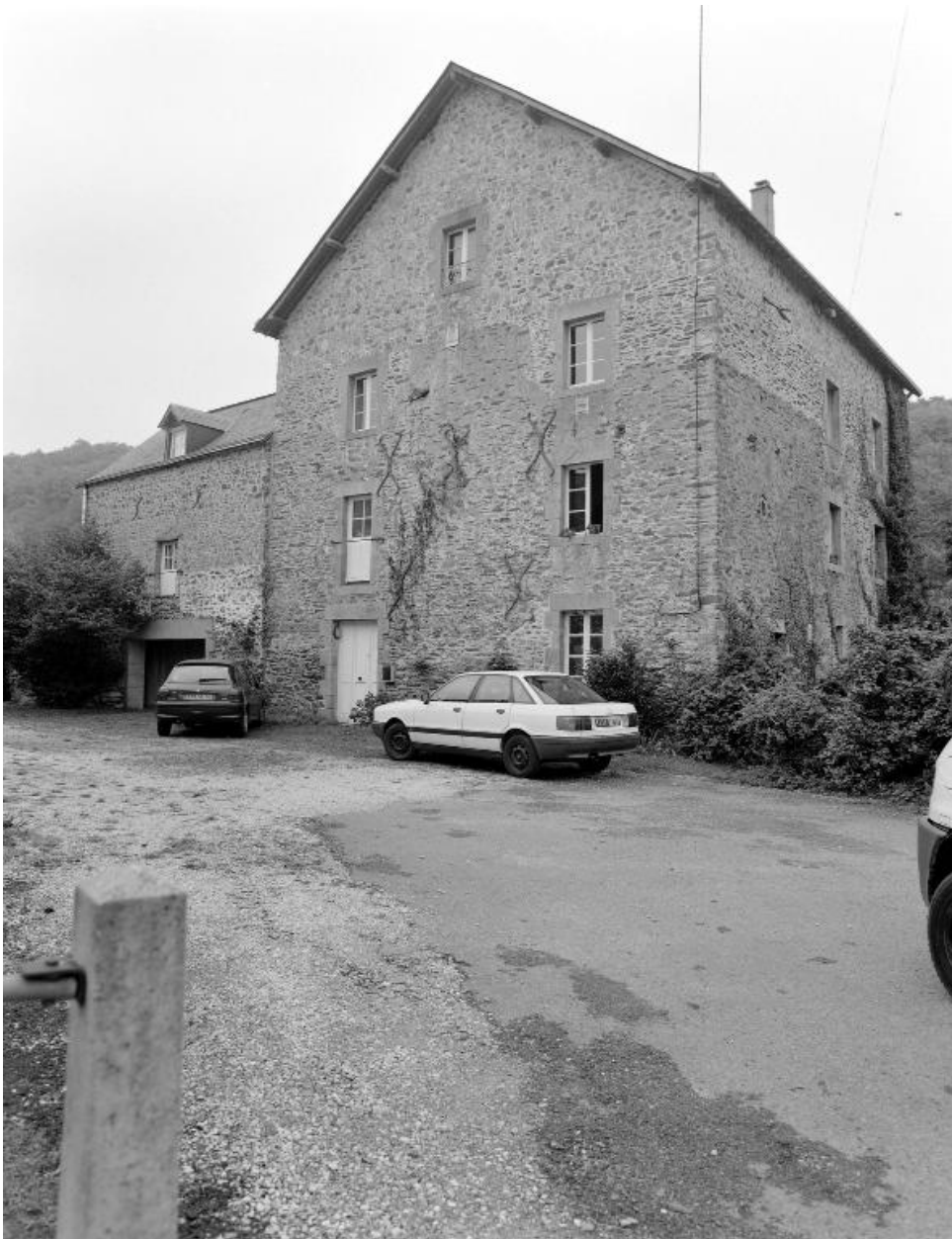
Elévation nord-ouest du moulin, sur la cour.
