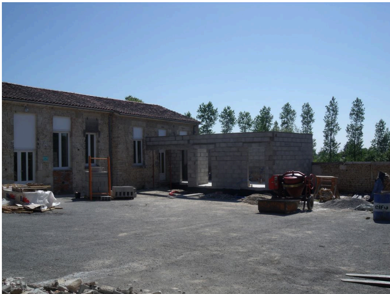
Constructions de sanitaires sur le côté est de la cour orientale en 2010.
