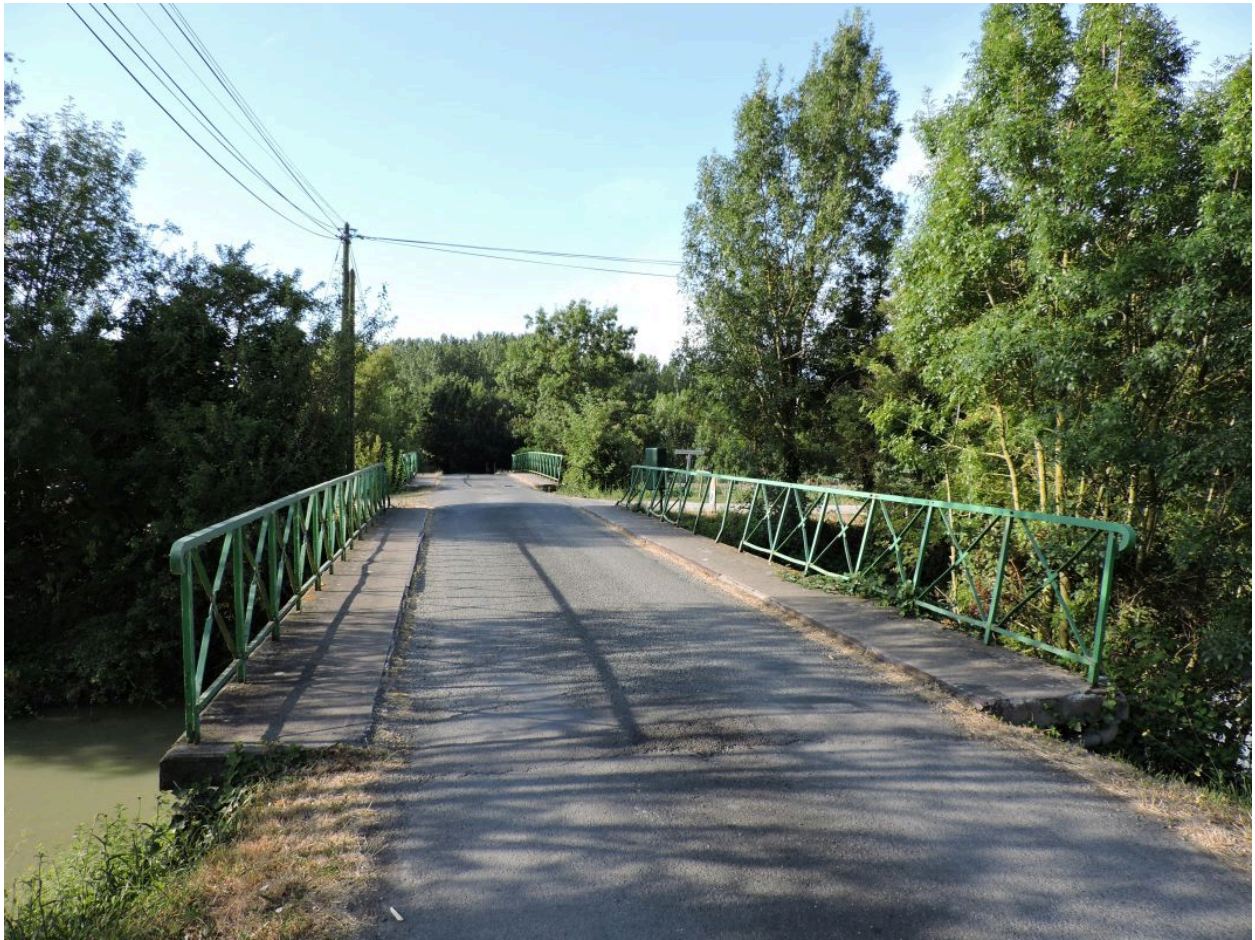
Le pont central, sur le canal de Vix, et le pont sud, sur le Contrebot de Vix, en arrière-plan, vus depuis le nord.
