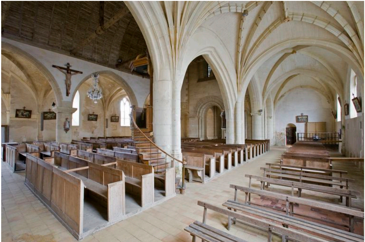
Vue d'ensemble du bas-côté nord
