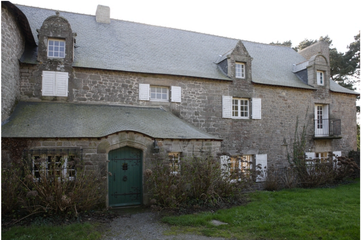
Vue de la façade nord.
