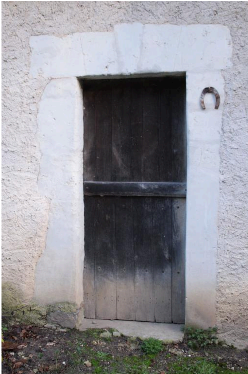
Maison : porte de la buanderie.
