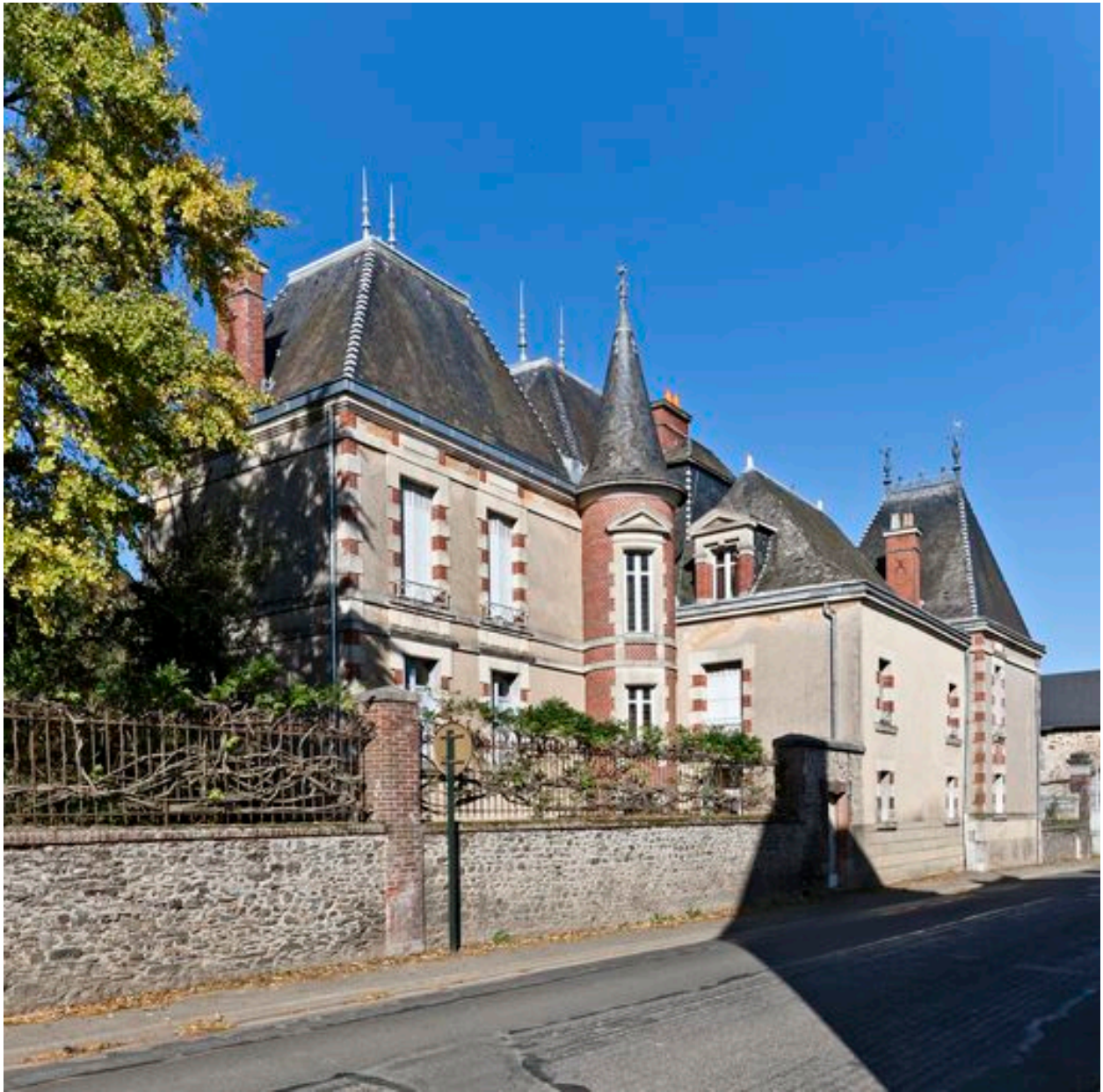
Vue d'ensemble depuis la rue.
