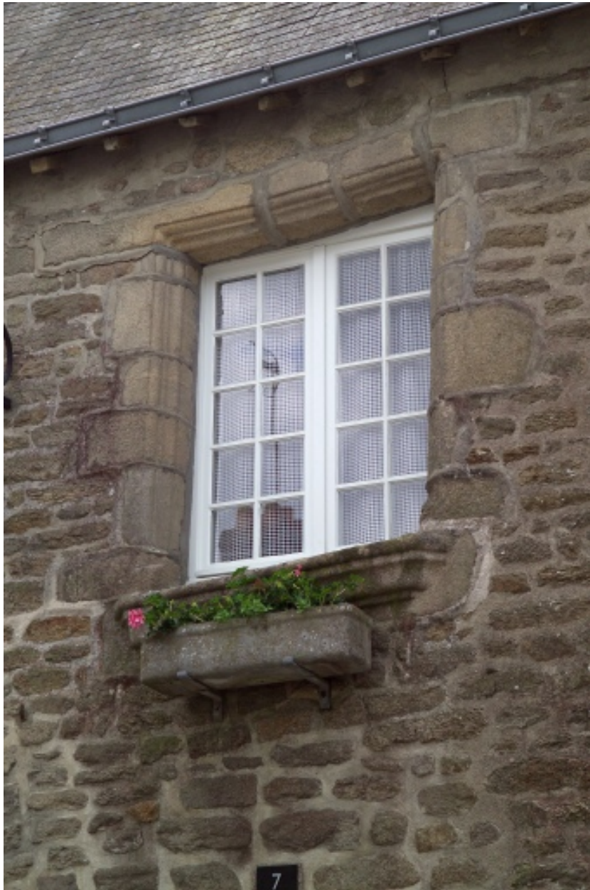
Détail de la baie centrale de la façade nord.
