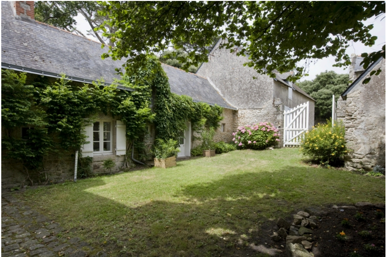
Logis. L'aile ouest, depuis le sud-est.
