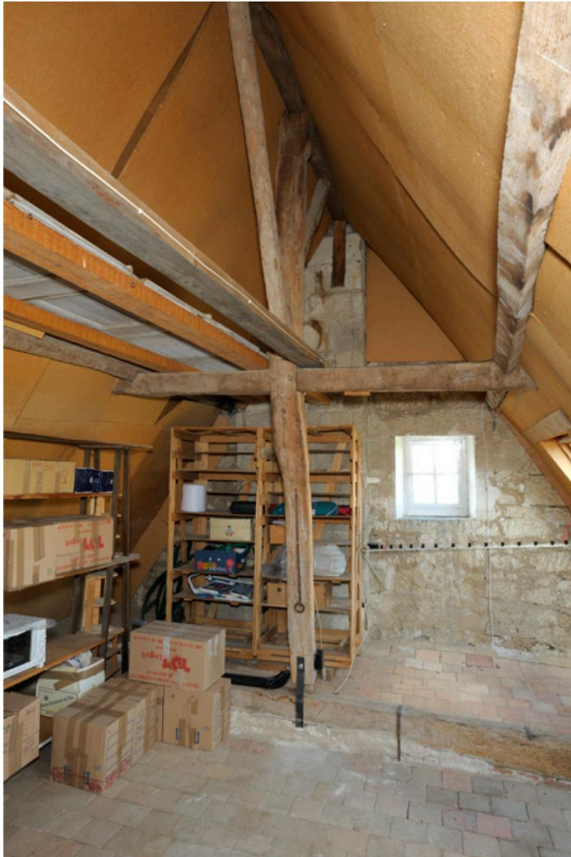
Charpente du corps ouest : on note les pannes sous arbalétrier, maintenues par une encoche dans l'entrait retroussé.
