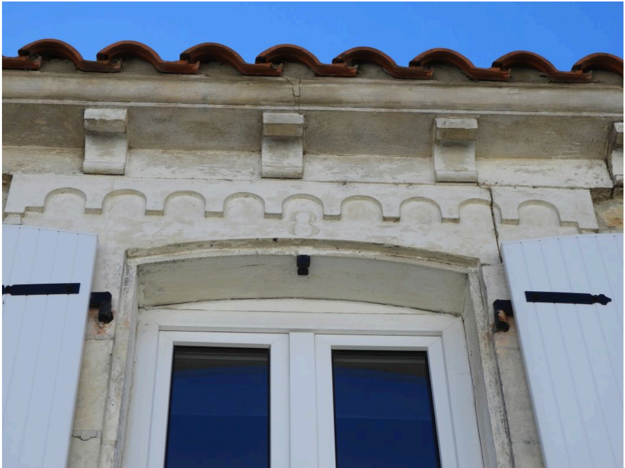
Détail de la façade : corniche à modillons, linteau crénelé portant le chiffre 8 (partie de la date 1892).
