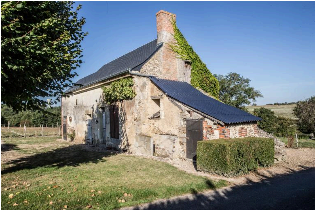
Ferme 1, vue de volume avec façade antérieure.
