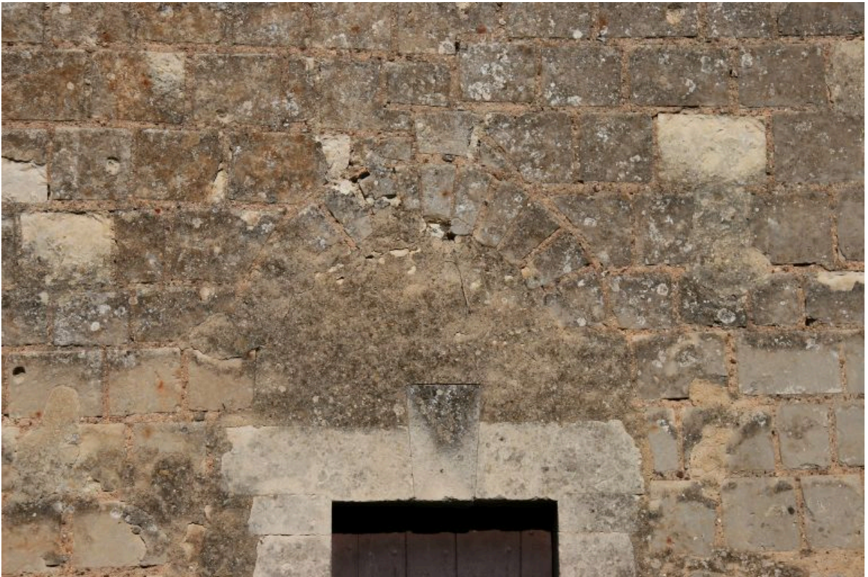
Mur sud de la nef, mise en œuvre : vestige d'un plein cintre.
