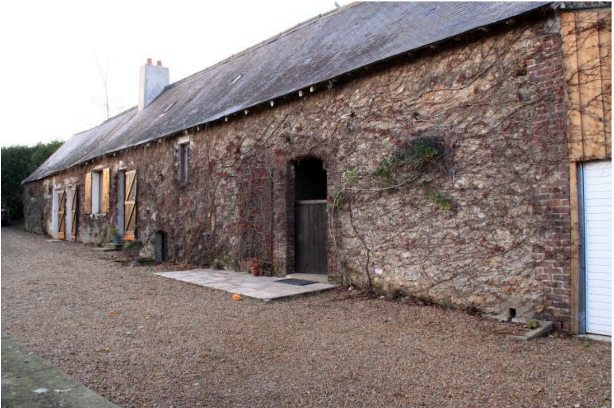
Ferme 5 (p. 1172, 1835) : façade sur cour.
