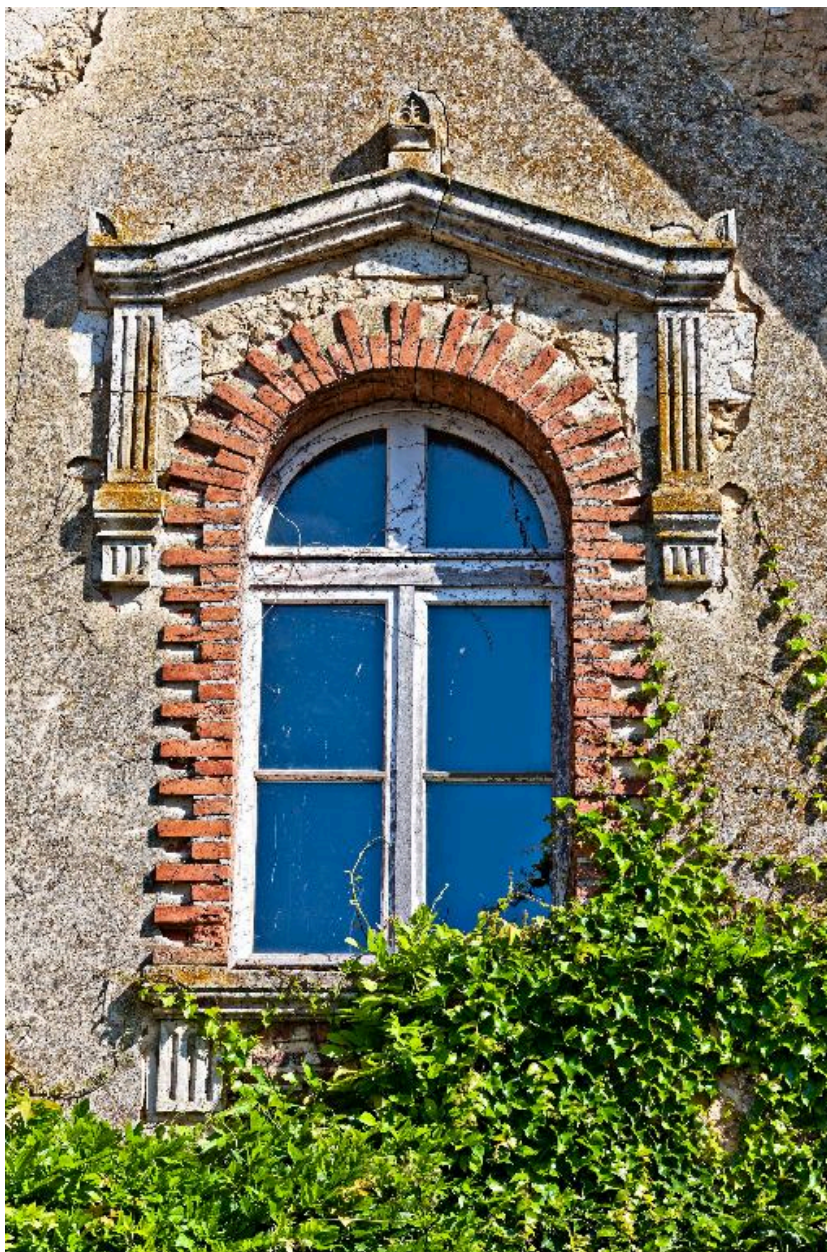
Détail de l'élévation antérieure de l'étude de notaire.
