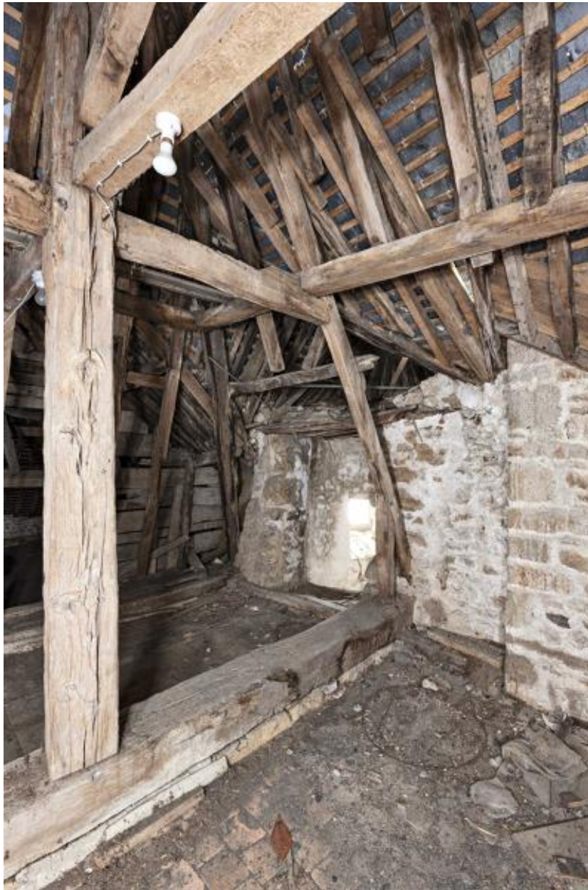
Charpente du corps de logis arrière, ferme sud.
