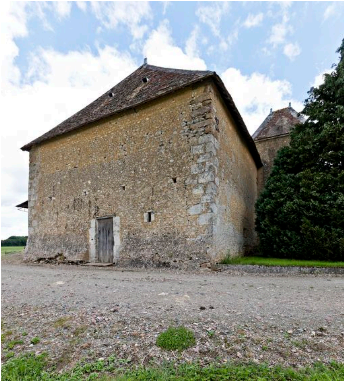
mur-pignon gauche de la grange-étable-fenil
