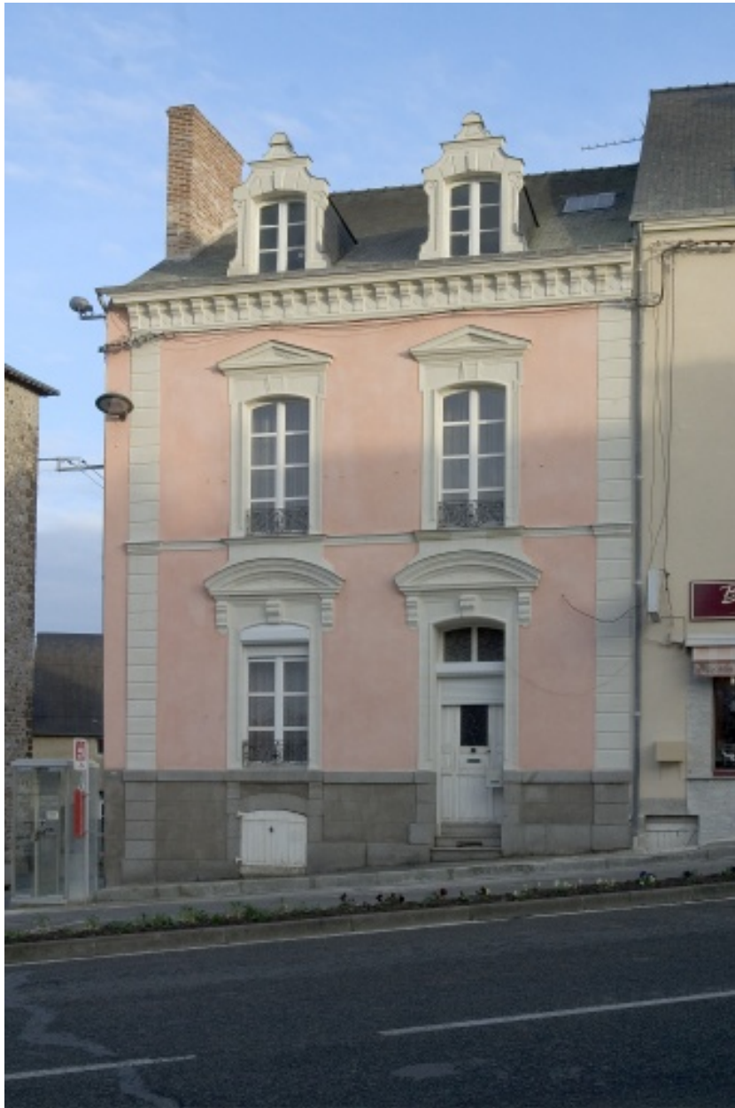
Vue de la façade principale, en cours de ravalement, depuis la place.
