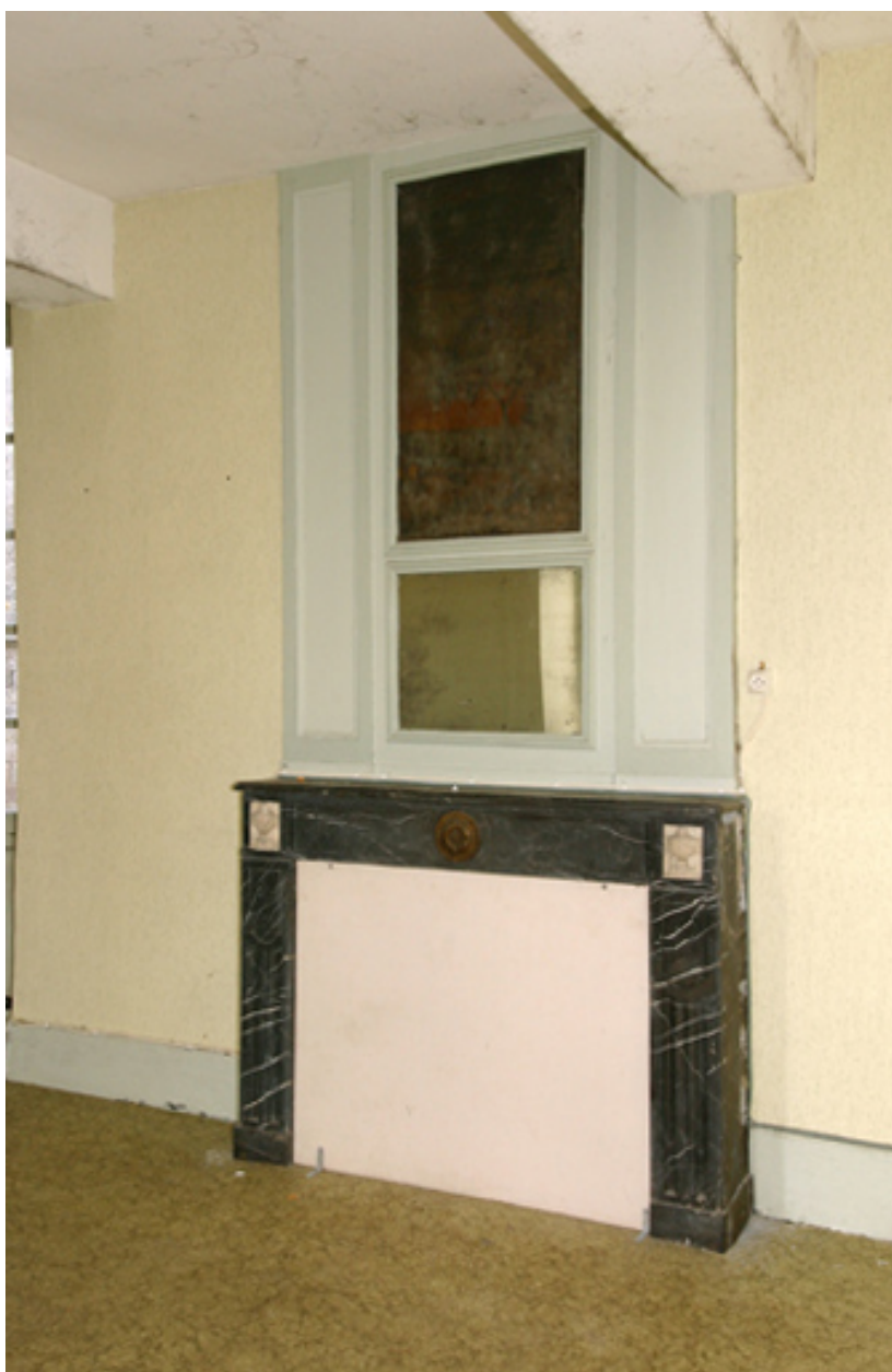
Cheminée à l'étage de l'aile est.
