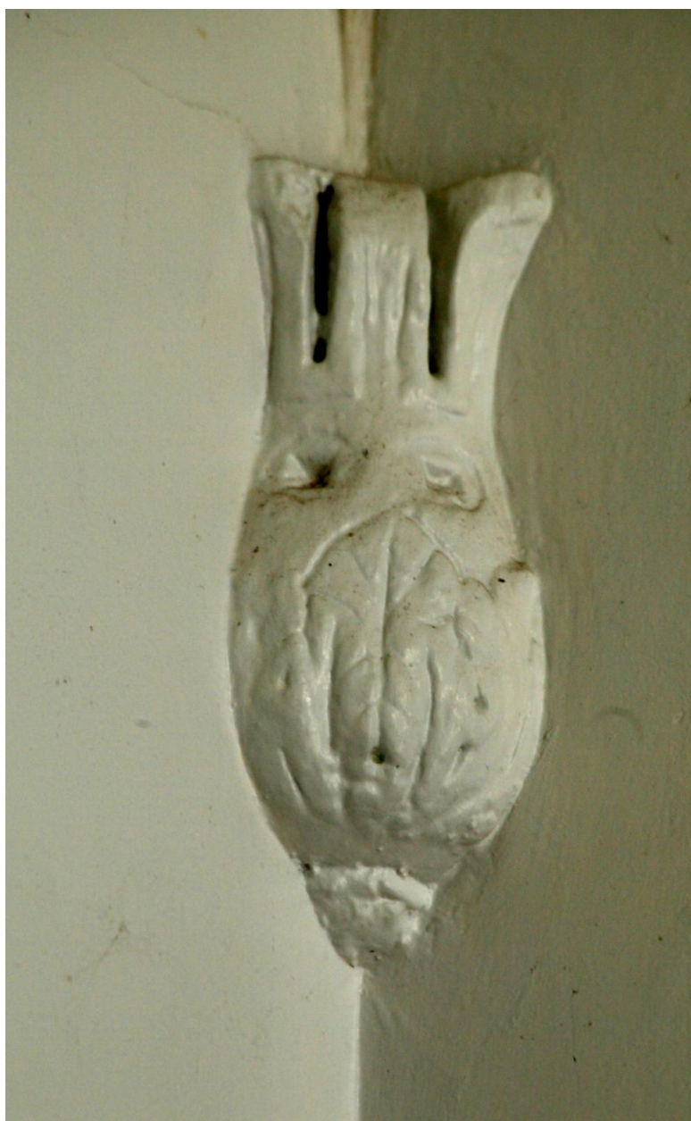
Rez-de-chaussée, voûte du vestibule : culot 2.
