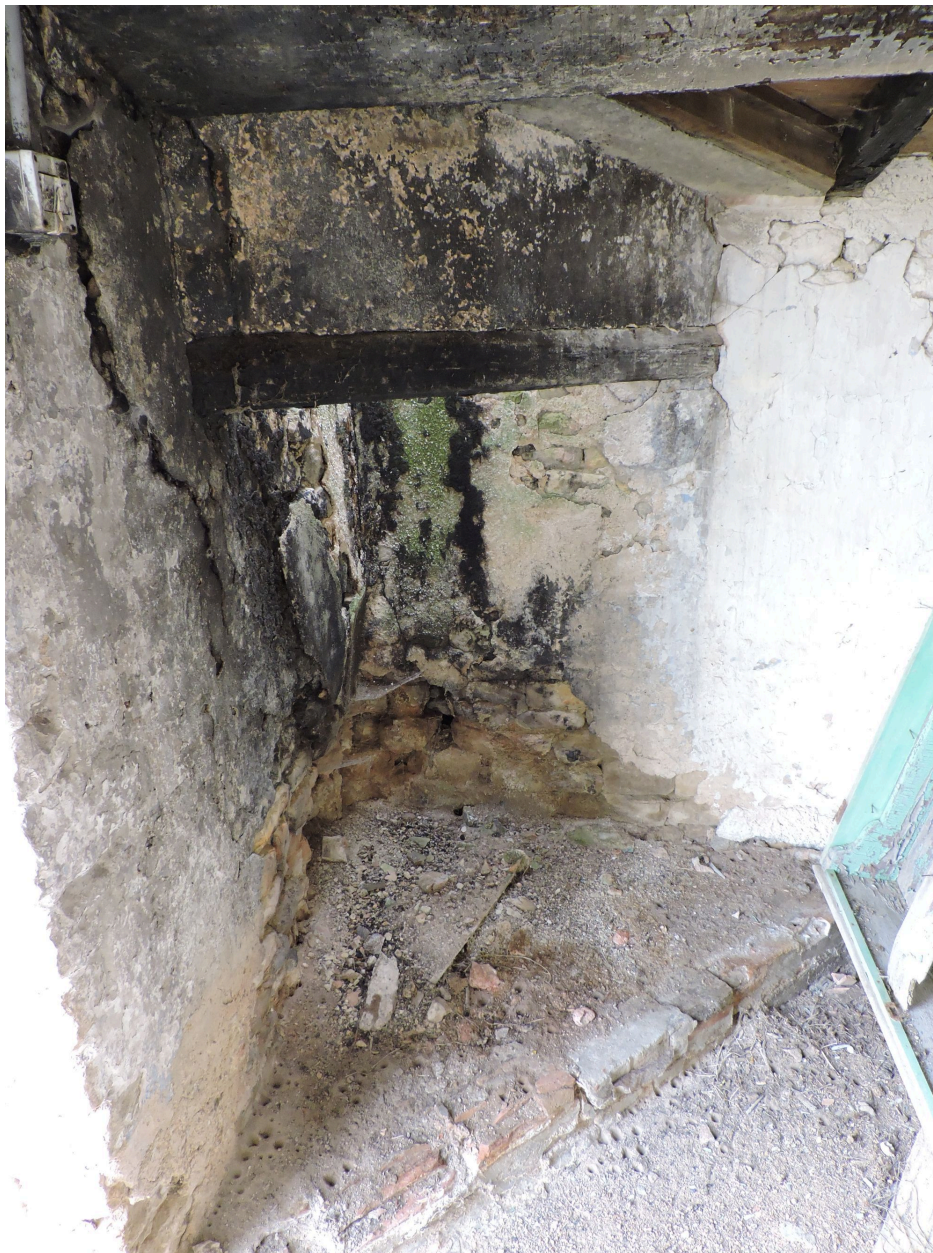
La cheminée dans la buanderie accolée au nord du logis.
