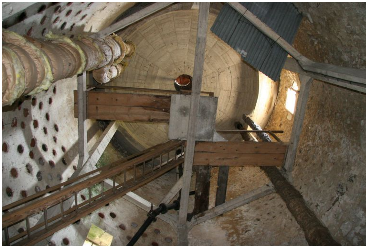
Armature en béton du château d'eau.
