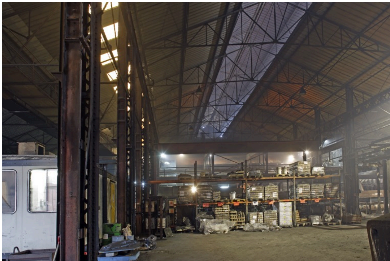
La halle de fonderie : vue intérieure depuis le nord.
