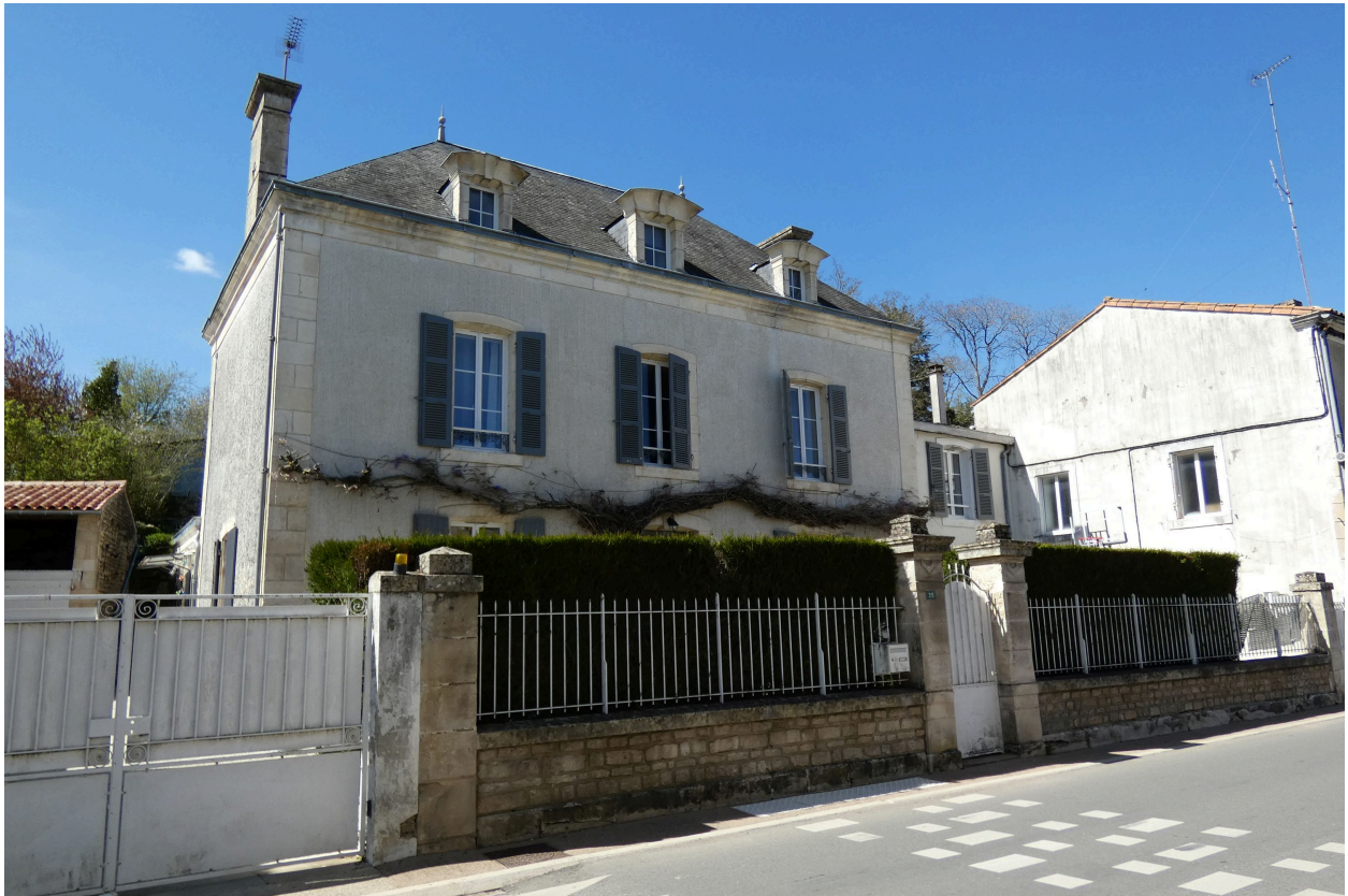
La maison vue depuis le sud-est.
