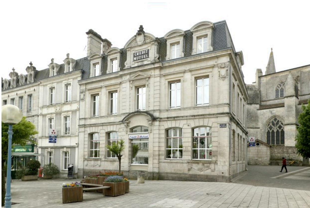
Vue de trois-quarts prise du nord-ouest.
