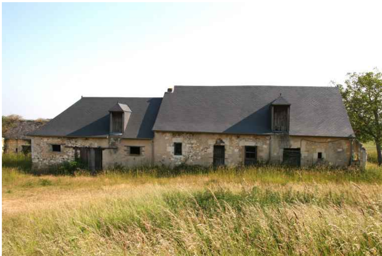
1ère maison d'habitation : façade sur cour.
