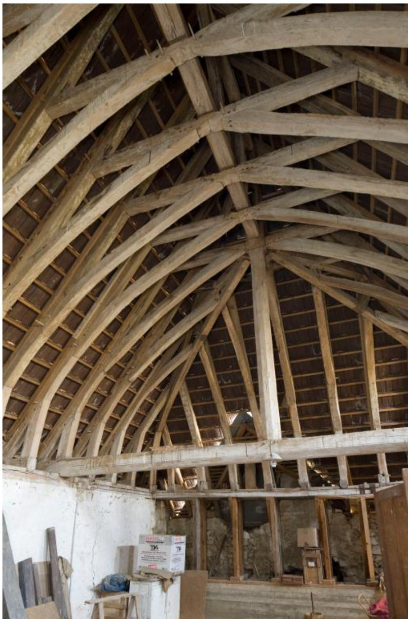
Chapelle : charpente et mur ouest (reconstruit).
