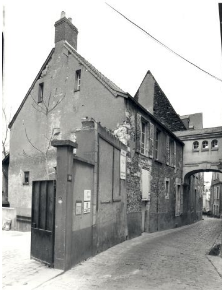
Logis postérieur gauche : élévation sur rue.
