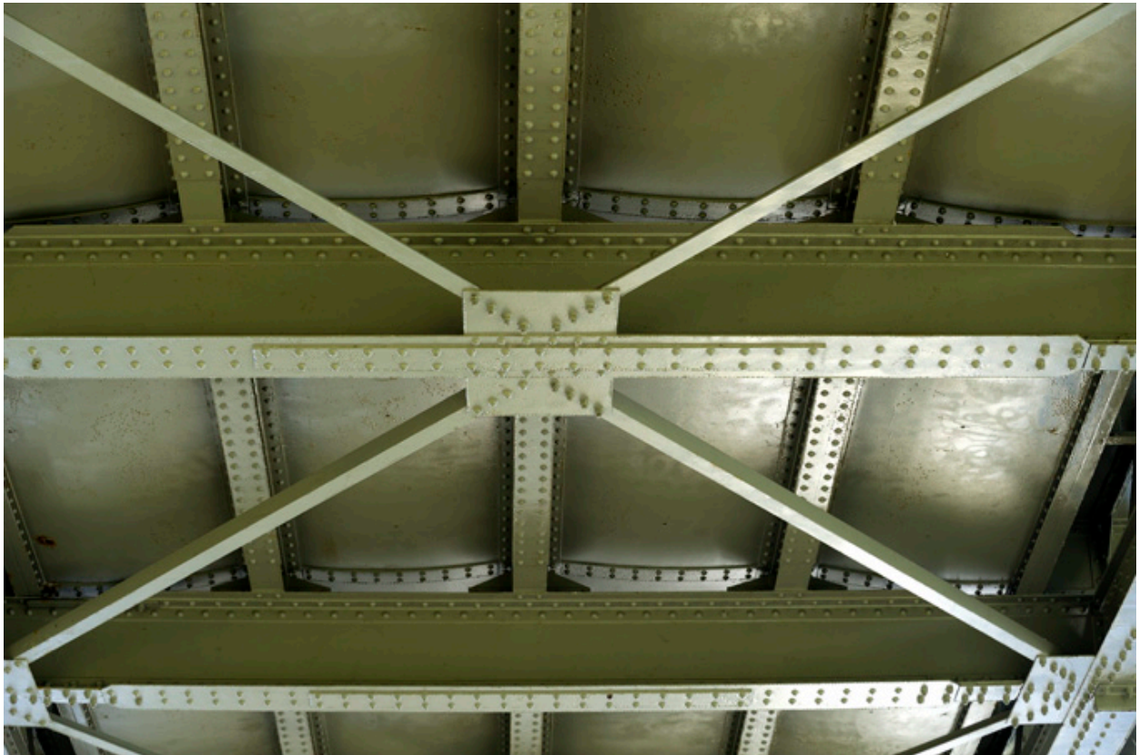
Charpente métallique soutenant le tablier (détail)
