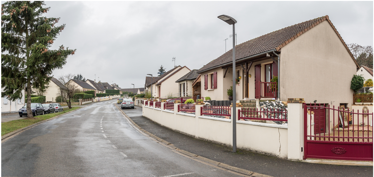
Un lotissement pavillonnaire des années 1980, rue Jean Moulin.
