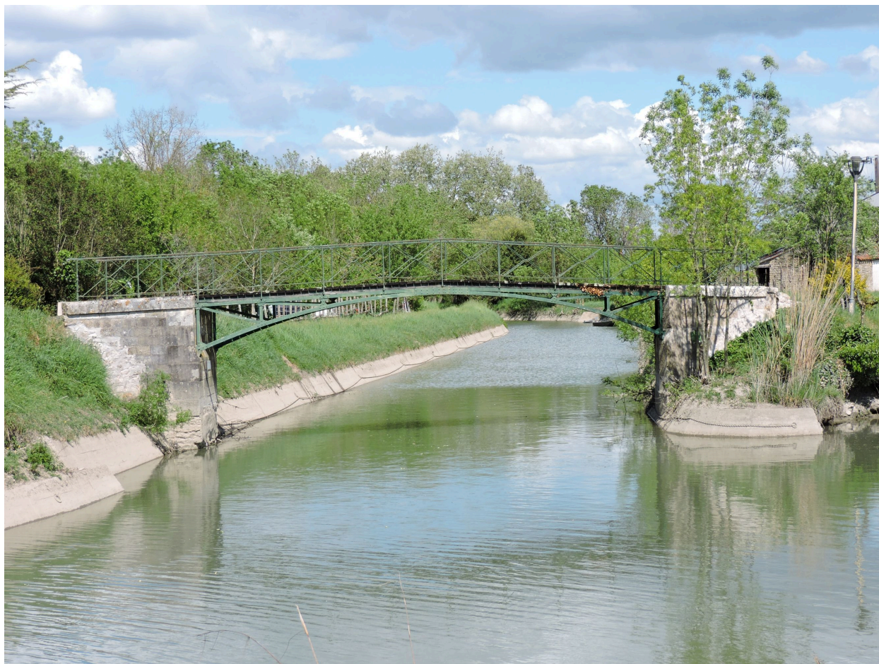
La passerelle enjambant l'embouchure de la Jeune Autise, vue depuis le sud-ouest.
