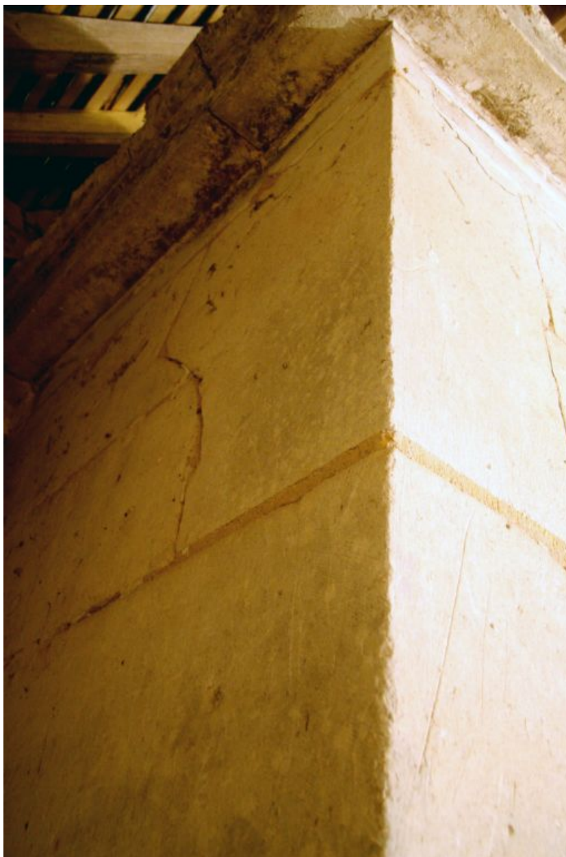
Ancien château, cheminée 1er étage : détail de stéréotomie.
