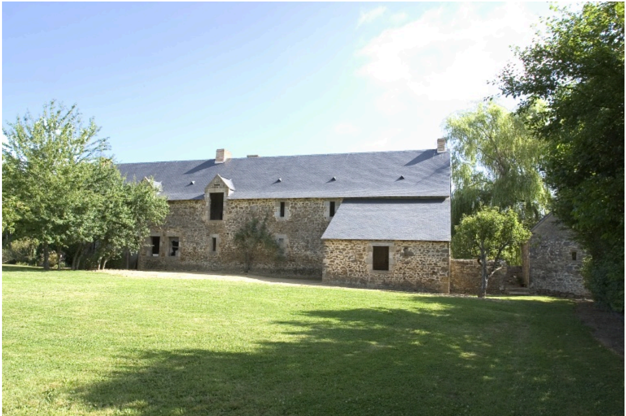
La façade postérieure de l'étable à chevaux-fournil vue depuis le sud-ouest.
