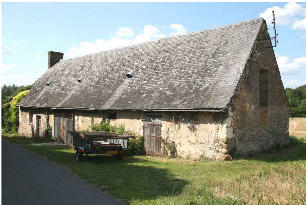
Façade antérieure sur rue.
