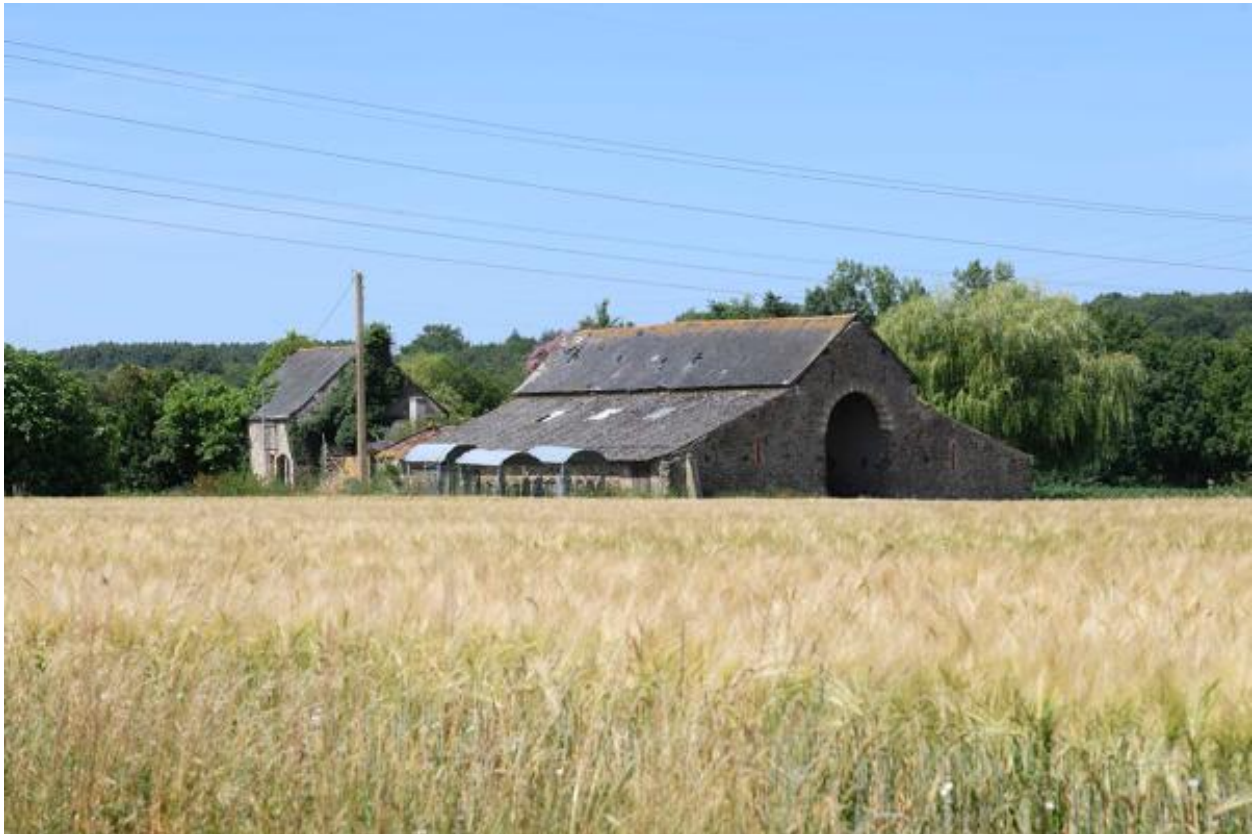
Vue de la ferme depuis l'est.
