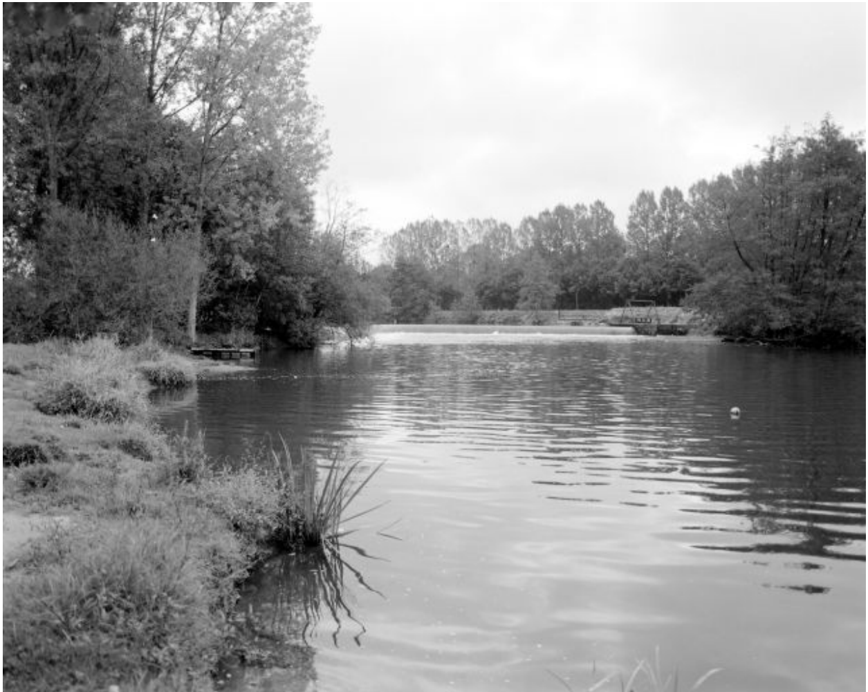
Le barrage et le pertuis des Communes vus de la rive droite de la Mayenne en aval.
