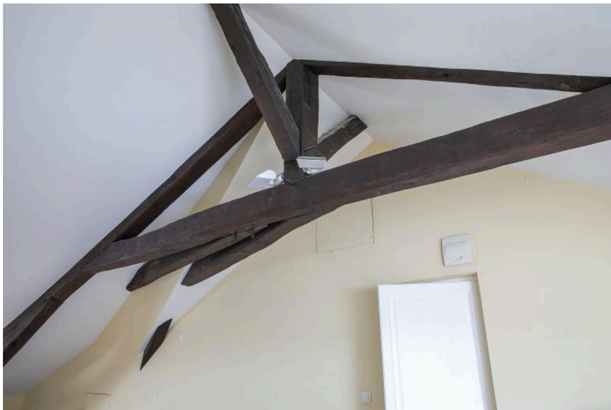
Vue de la charpente depuis l'étage sous comble.
