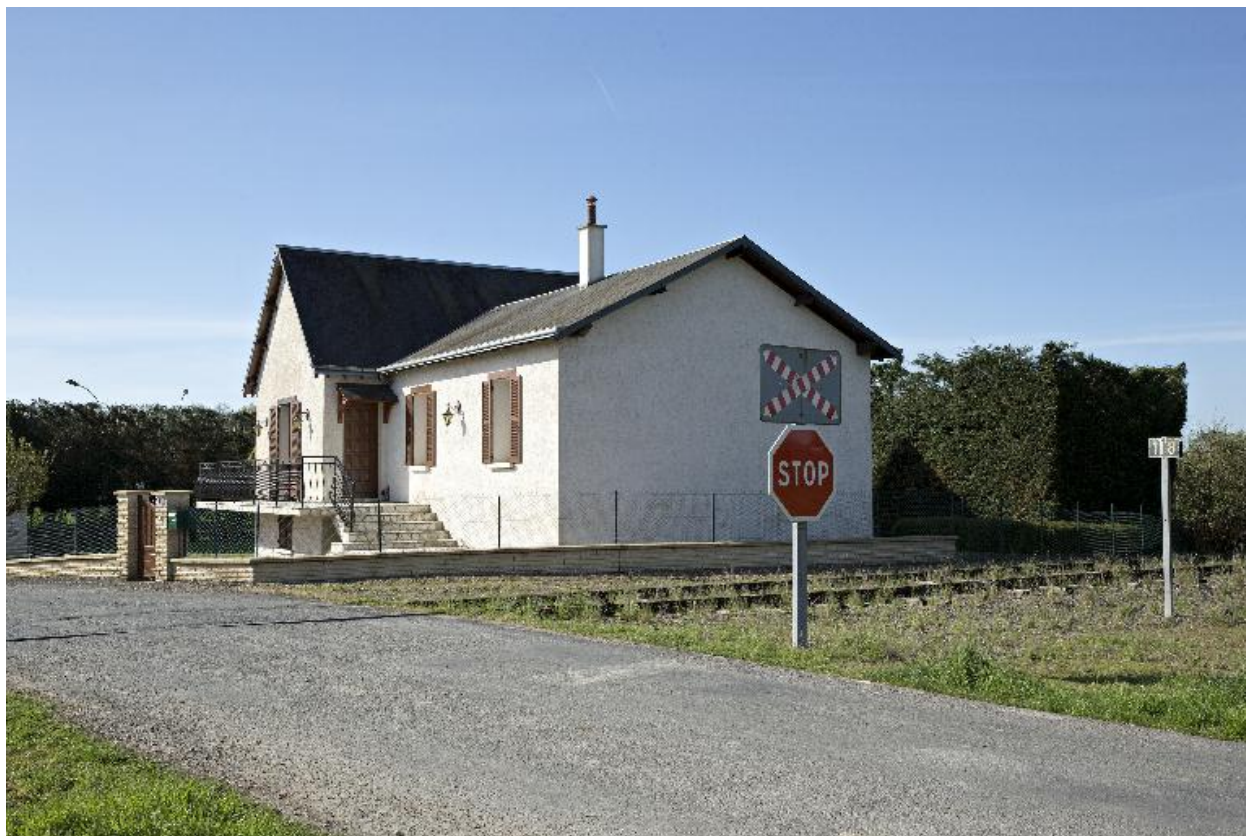
Ruillé-sur-Loir, le Grand Parc : maison de garde-barrière du PN 118.
