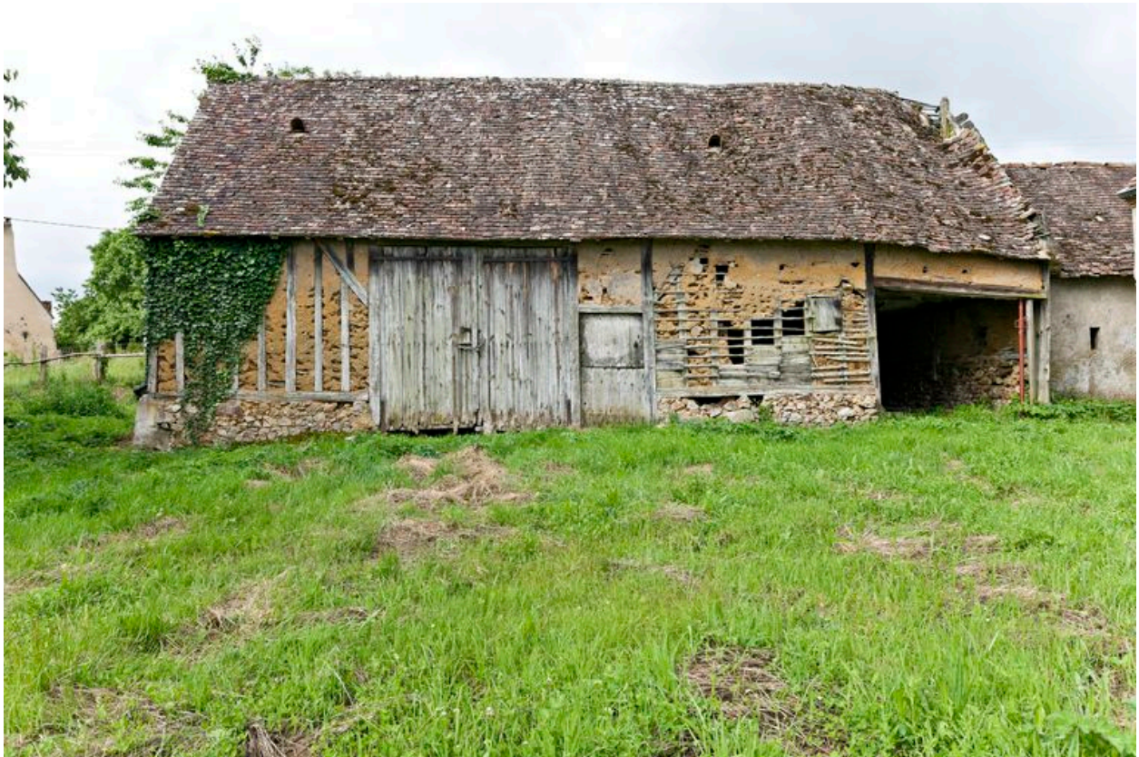
Élévation antérieure de la grange-écurie-remise.
