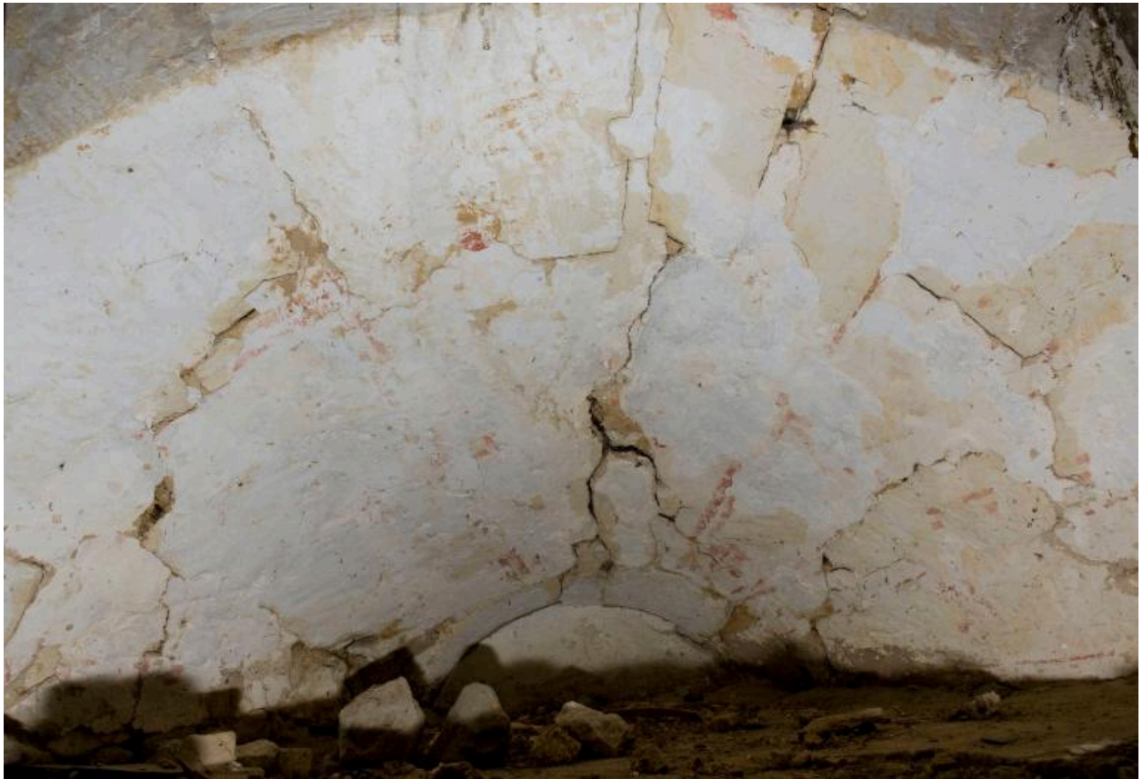
Ancienne chapelle, mur nord, fenêtre, intrados : décor de faux-appareil et fleurettes.
