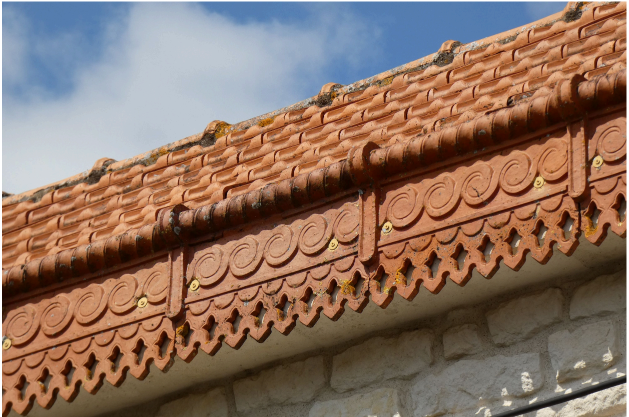
Détail des bordures de rive soulignant le toit de la maison.
