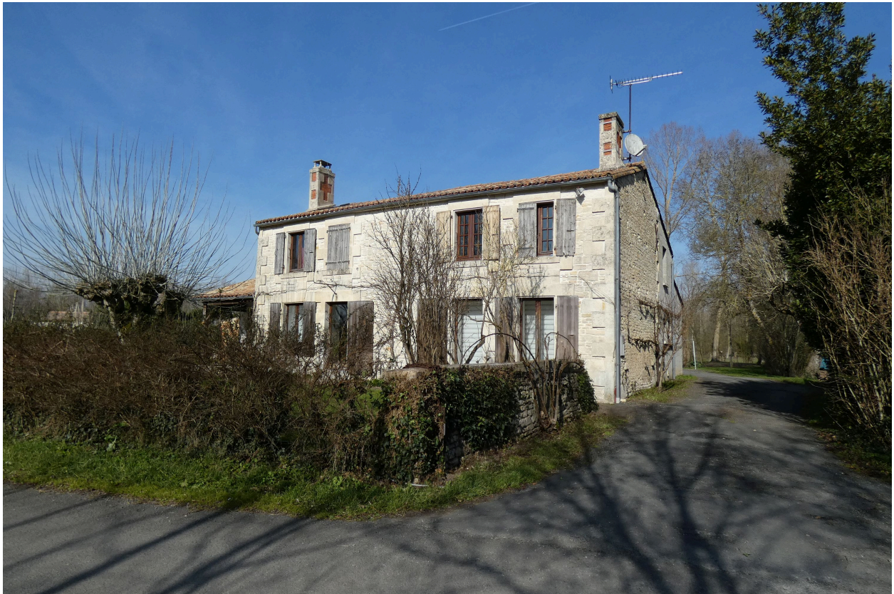
Vue depuis le sud.
