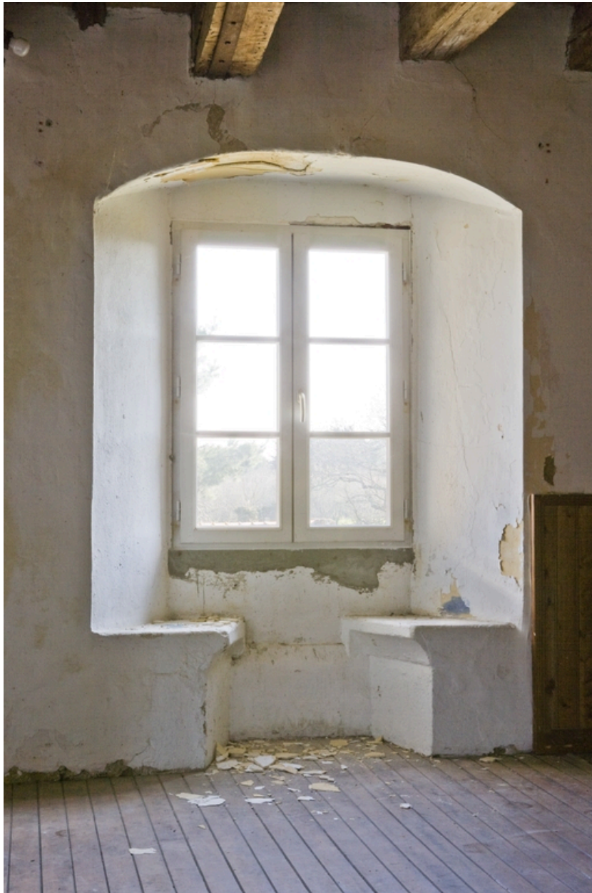
Aile ouest. Salle haute. Détail de la fenêtre à coussièges.
