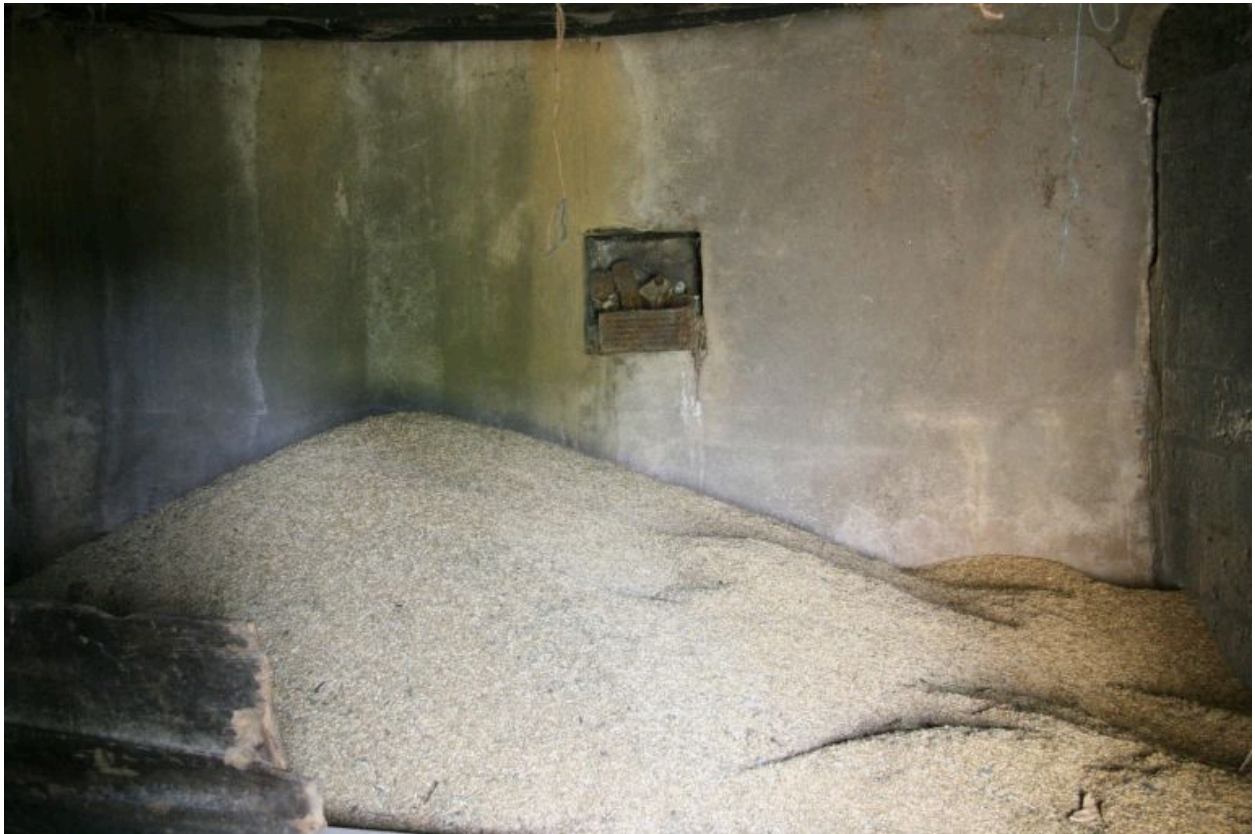
la chambre à feu : petite baie sur le mur du fond.
