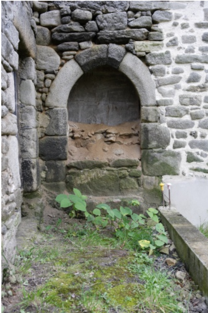
4e logis. Façade nord. Porte.
