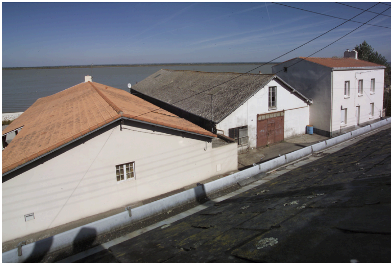
Vue partielle de la façade sud de l'îlot 2 vers l'amont.
