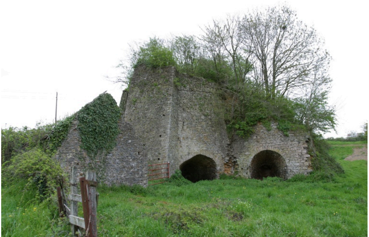
Le four et le hangar vus depuis l'ouest.
