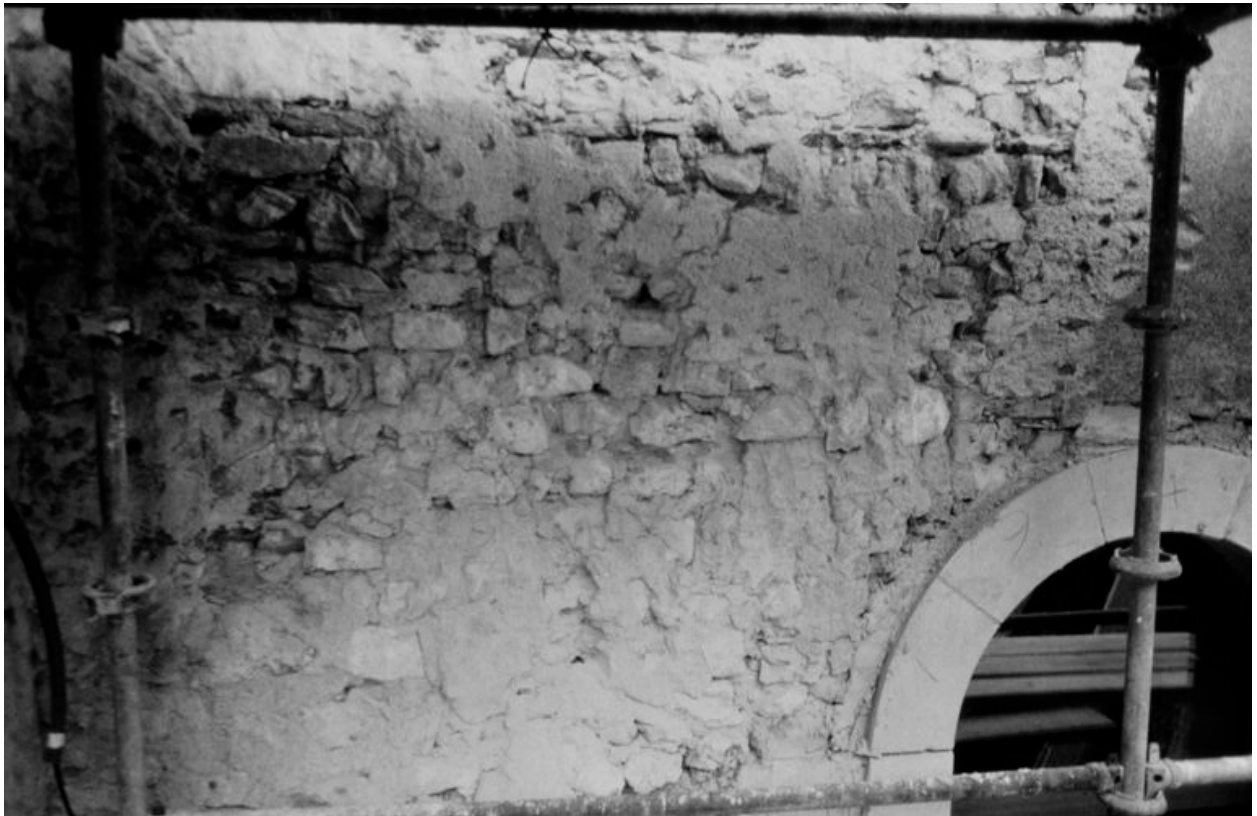
Choeur, élévation extérieure sud (sur cour) : détail de maçonnerie à gauche de la baie en plein cintre, pendant les travaux de ravalement, février-mars 1997.
